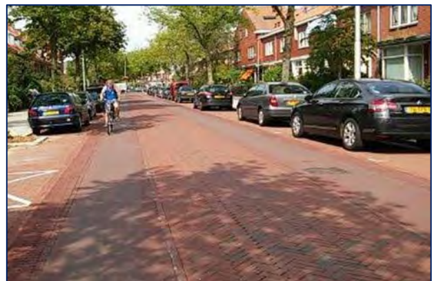
Figuur 16: Voorbeeldontwerp GOW 30 met fietsstroken en klinkerverharding
