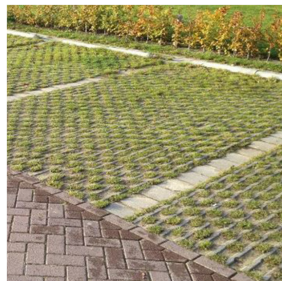
Parkeervakken omvormen naar waterdoorlatende verharding
