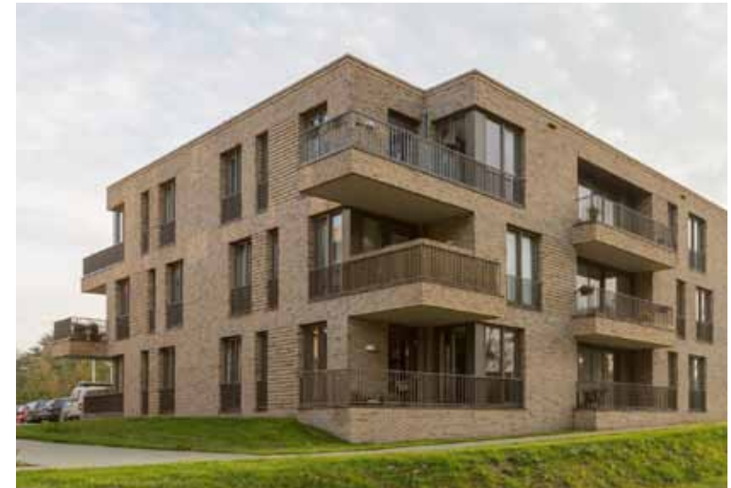
balkons en buitenruimten op de begane grond mogen deels uitkragen buiten bebouwingsvlak, bij voorkeur geïntegreerd op de hoeken
