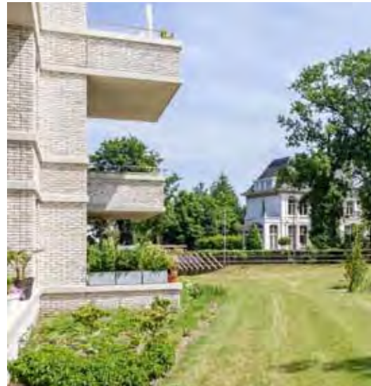
gebouw staat in de parktuin afgebakende buitenruimte op de begane grond
