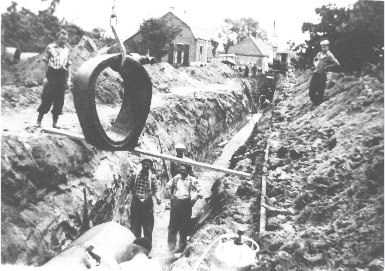
Aanleg riolering Kornet van Limburg Stirumstraat (Olst 1960)
